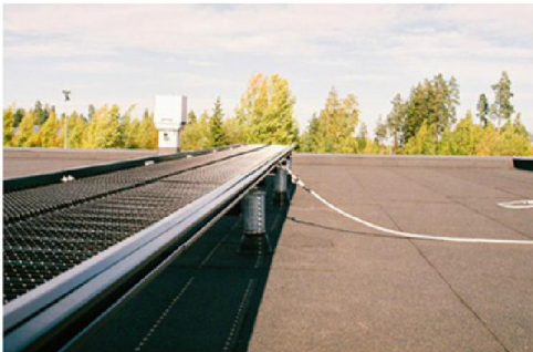
Pollareiden päälle rakennettu 700 mm leveä huoltotaso turvakiskolla.
