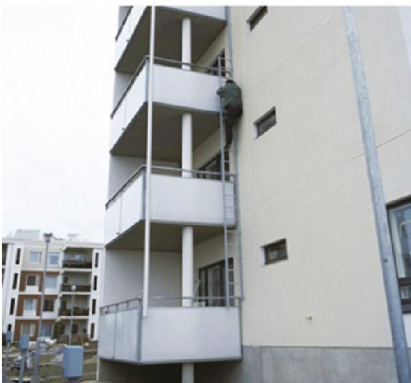
Pollareiden päälle rakennettu 700 mm leveä huoltotaso turvakiskolla.
